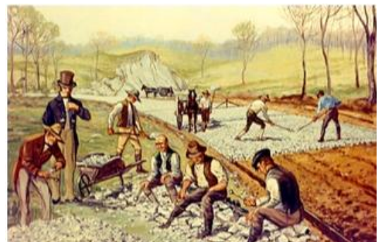
Construcción de una carretera durante el siglo XIX.
