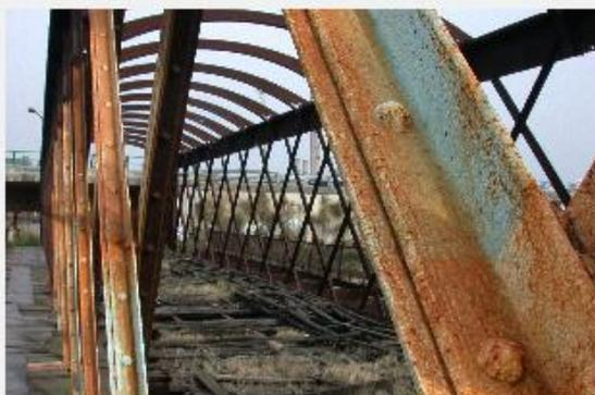
La corrosión de metales, aunque tiene un mecanismo relativamente complejo, consiste básicamente en la combinación del metal con oxígeno, produciéndose el óxido del citado metal. Uno de los metales que más frecuentemente sufren este proceso es el hierro.
