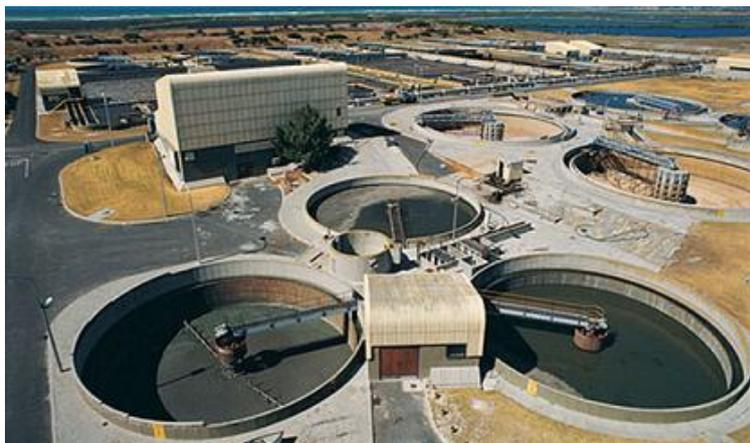
Un ejemplo donde vemos la utilidad clara de la separación de componentes de una mezcla heterogénea. Se trata de una depuradora de aguas residuales. En primer plano, piscinas de decantación, donde los residuos más grasos flotarán sobre el agua.
