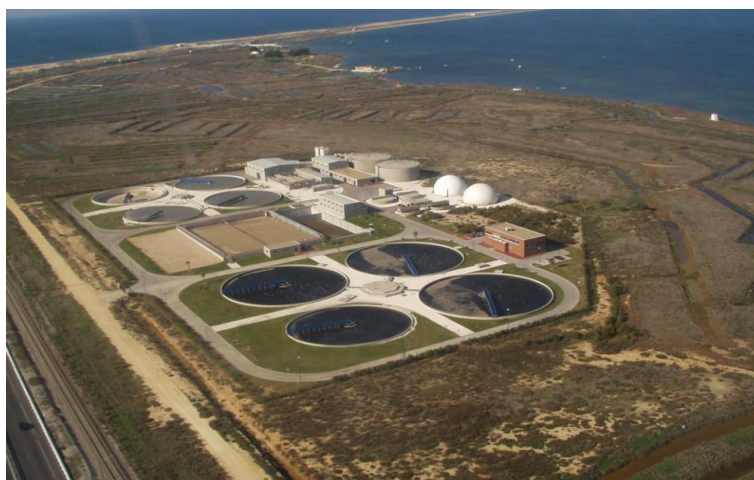
EDAR Cádiz- San Fernando. Fuente: OHL Medio Ambiente, Inima
