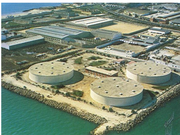
Depósitos de agua potable de la ciudad de Cádiz. Fuente: Consorcio de agua de la zona gaditana
